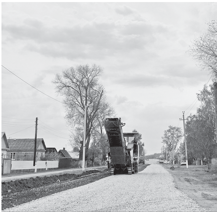
Идёт строительство дороги.
