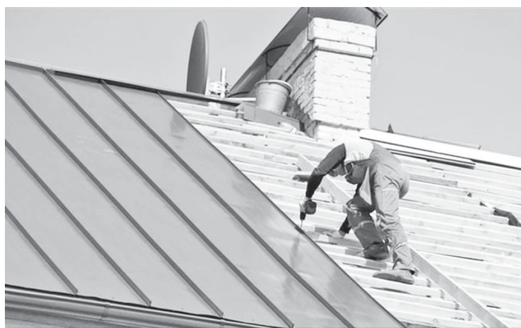
Капитальный ремонт крыши.
